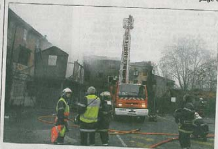
Le bâtiment central, très endommagé, est le plus ancien du site.
